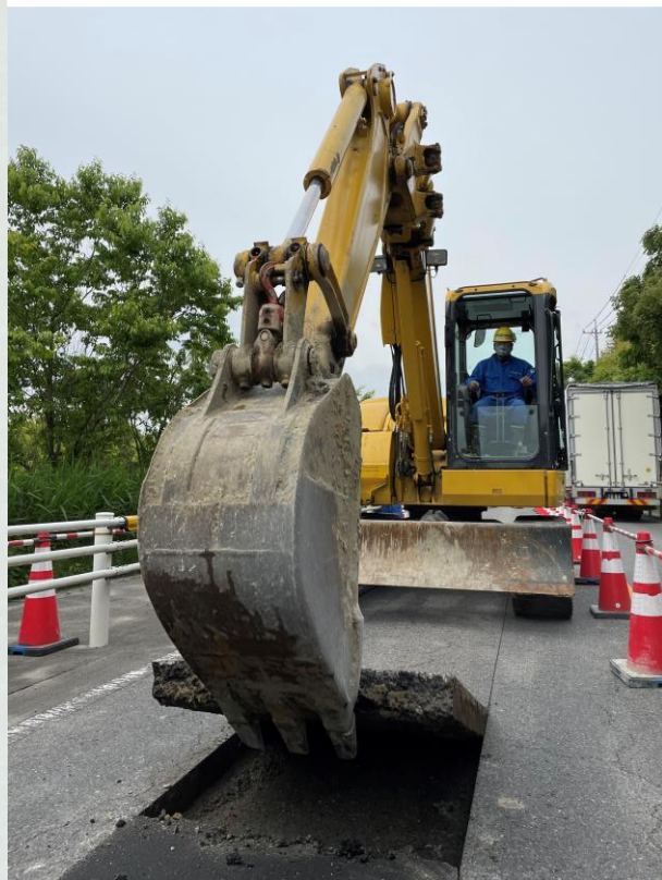
路面の割取り
