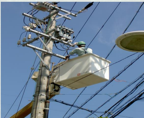
引込線工事[電気]
