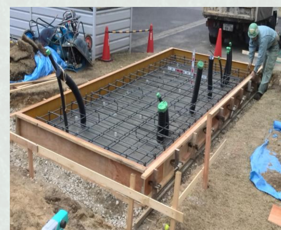
電気設備基礎工事[電気土木]
