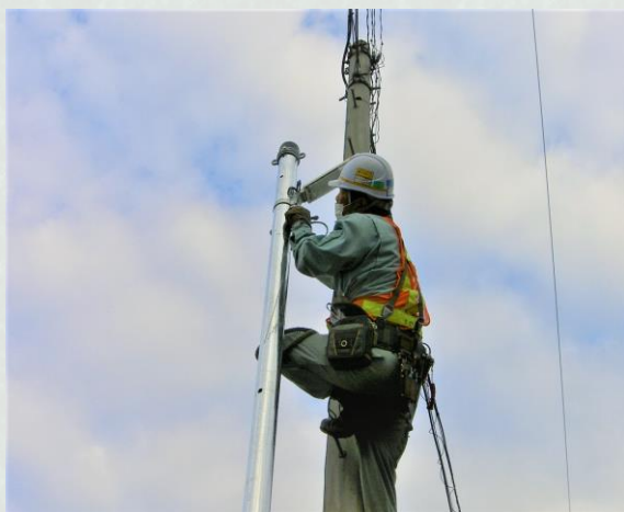
街路灯工事[電気]
