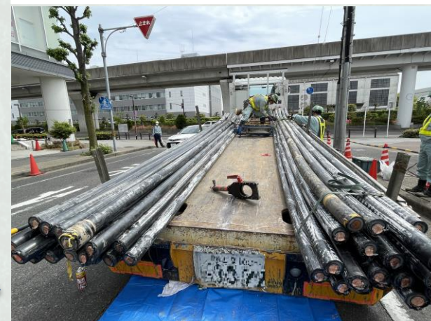
ケーブル撤去完了
