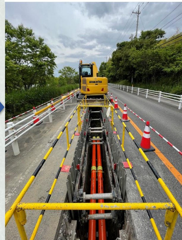
埋設配管完了
