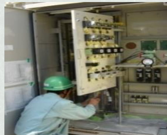
屋内外配線工事[電気]
