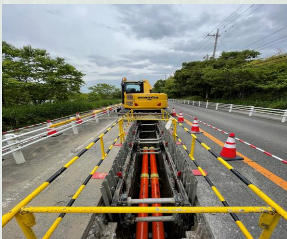
★埋設配管工事[電気土木]
